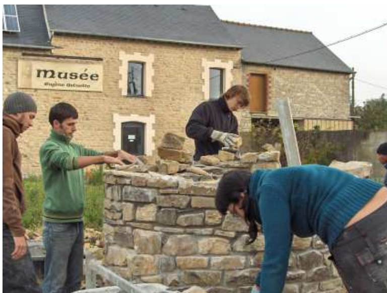
chantier 2007 en Bretagne
